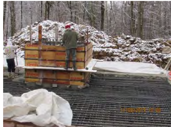
Foundation pour in progress
